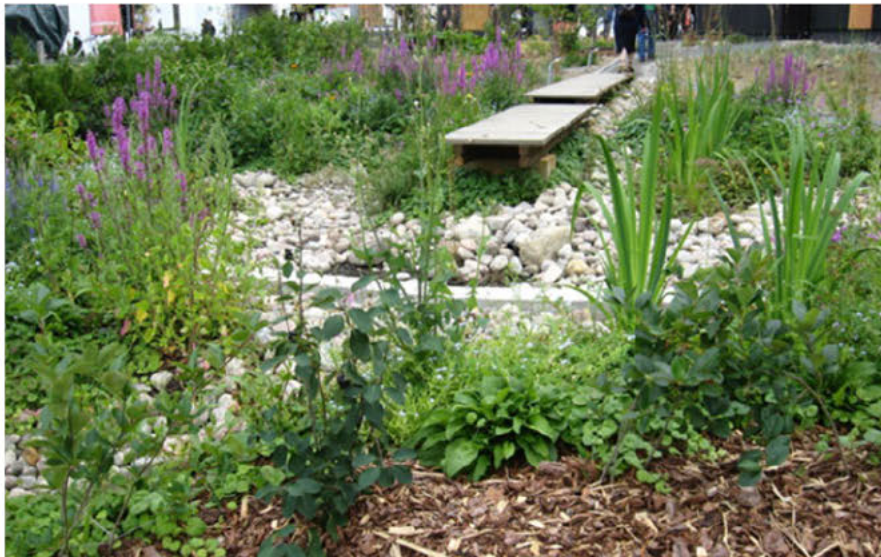
Kuva 12 Hulevesien muodostumista vähentävä puutarharatkaisu (Kuva Leena Sänkiaho)
