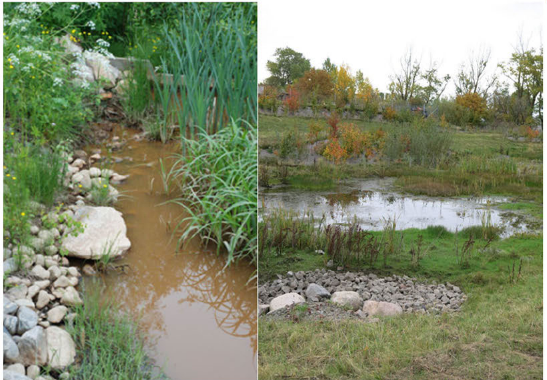
Kuva 13 Hulevesien laskeutusallas kiintoaineen positoa varten ja hulevesikosteikko (Kuvat Leena Sänkiaho)
